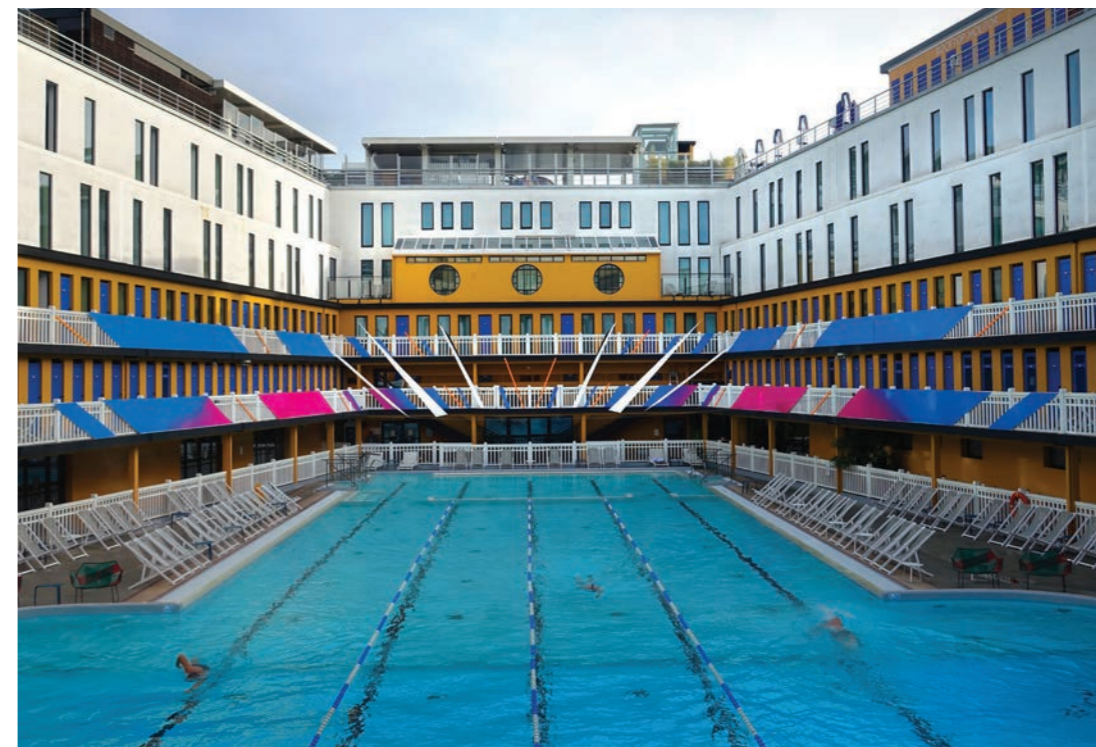
Installation sur les façades et les coursives du bassin extérieur de Molitor, Paris, 2023
